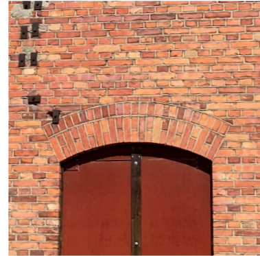
Valv över fönsteröppningar
