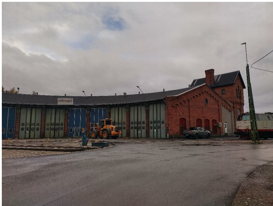
Foto på lokstallet. Det gamla vattentornet skymtas till höger i bilden
