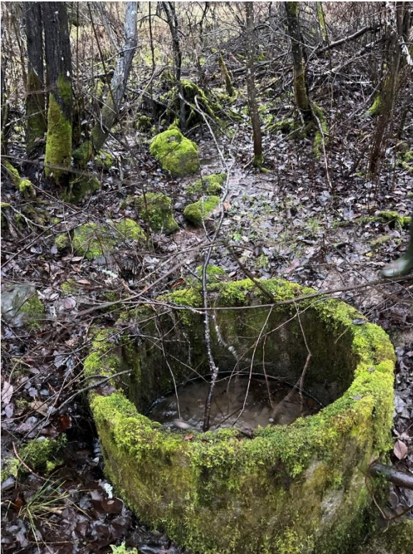
Figur 9. Brunn med stående vatten, cirka 10 cm. Sipprande vatten på vardera sida.
