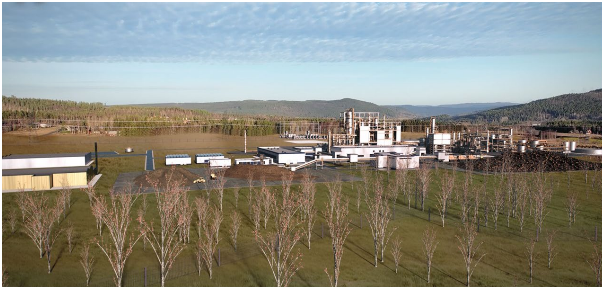
Illustrationen visar en flygvy från söder över Unipers planerade anläggning för produktion av flygbränsle
